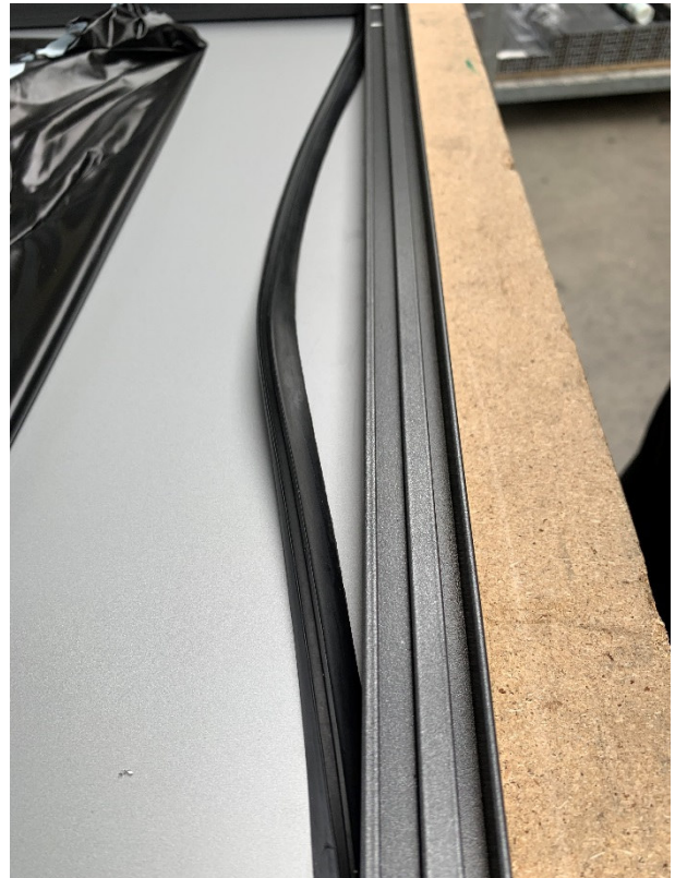
4. Die Enden auf beiden Seiten in das jeweilige Profil einstecken
